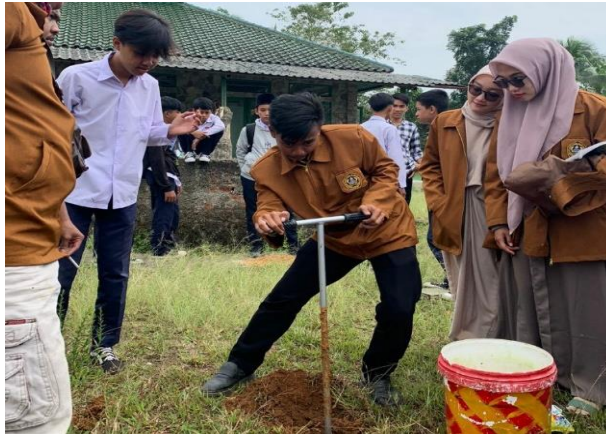
Gambar 5. Praktik pembuatan Lubang Resapan Biopori di Sekolah
