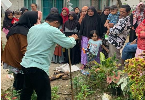
Gambar 4. Praktik pembuatan Lubang Resapan Biopori di masyarakat
